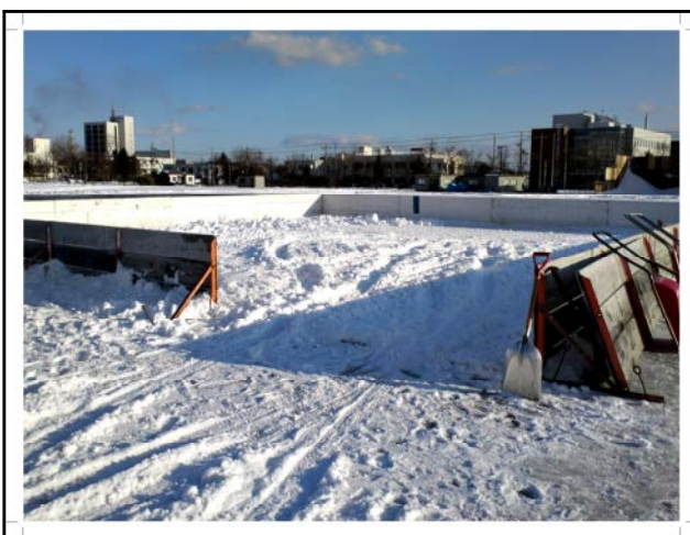
外枠が立った後は、下地となる雪を入れて踏み固めます。
